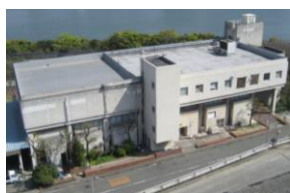
●大高洲庁舎 昭和51年（1976年）完成
