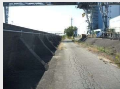
防潮堤（尼崎港）
