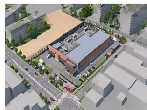
【南西側の上空から】
