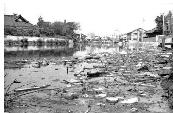
地盤沈下のため流れが止まり、ゴミためのようなになった大物川。昭和 40 年に埋立工事が行われ、現在は緑道公園となっている。（昭和 40 年（1965）、市広報課撮影）
