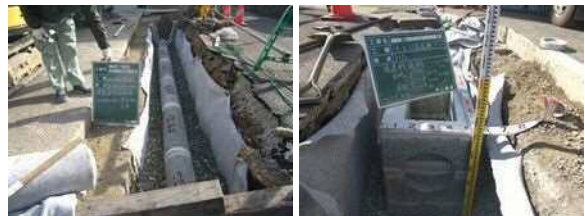
雨水浸透管・雨水浸透ますの設置
