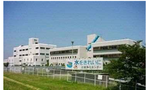
北部浄化センター
