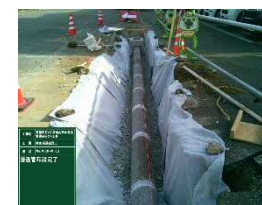
雨水浸透管布設
