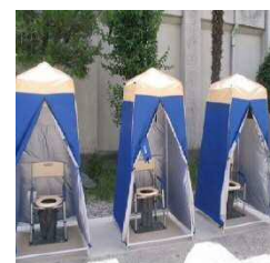
マンホールトイレ
