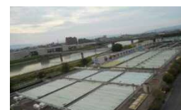
北部浄化センター
