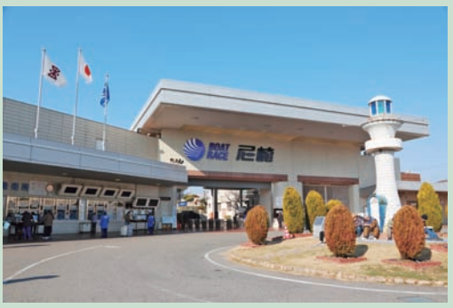
モーターボート競走場では、メインスタンドの改修等が予定されています。
