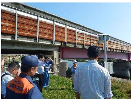
北部浄化センター（尼崎市）
