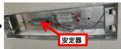
③ 安定器を確認してください 安定器の表面に 銘板 が貼られています
