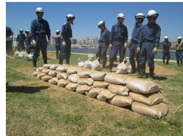
三段積み土のう
