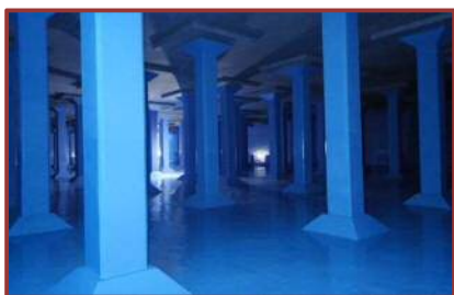
配水池の耐震化工事の様子
