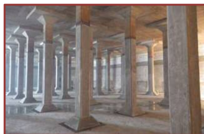
耐震化後の配水池の内部
