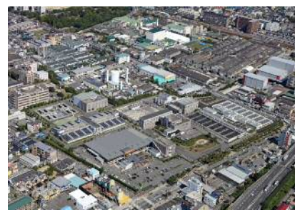
阪神水道企業団尼崎浄水場
