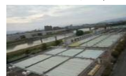
北部浄化センター
