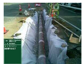
雨水浸透管布設
