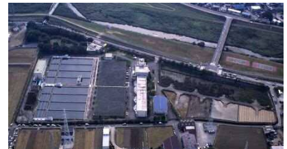
園田配水場 供用開始：昭和 42 年
