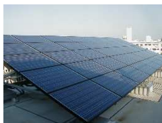
杭瀬小学校屋上
