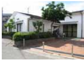
<西昆陽南会館>
