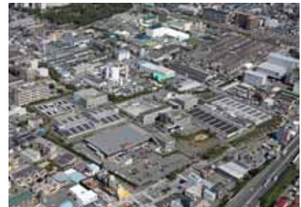
阪神水道企業団尼崎浄水場
