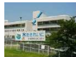
北部浄化センター
