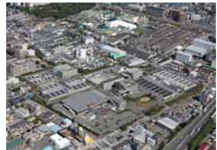
阪神水道企業団尼崎浄水場
