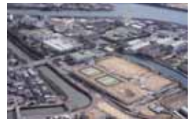
東部浄化センター 供用開始：昭和 57 年
