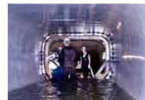
管きよ改築工事 (管更生工事)
