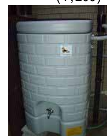
雨水貯留タンク
