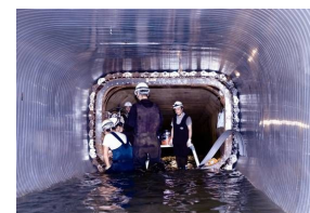
管きょ改築工事 (管更生工事)
