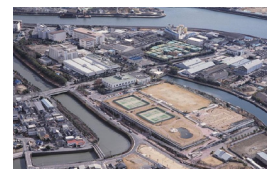
東部浄化センター 供用開始：昭和 57 年
