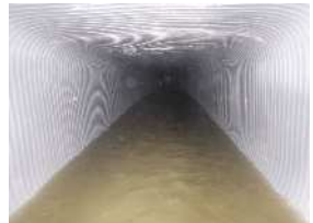
管きよ改築工事 (管更生工事)
