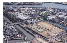
東部浄化センター 供用開始：昭和 57 年
