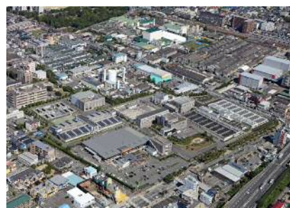
阪神水道企業団尼崎浄水場
