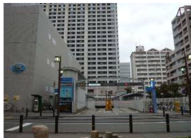
(第二地区駐車場)
