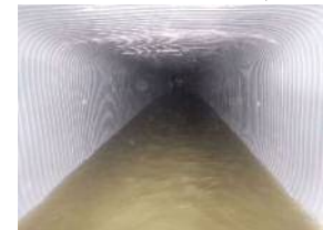
管きょ改築工事 (管更生工事)
