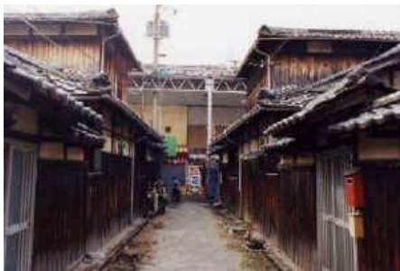
老朽した木造住宅が密集する地区
