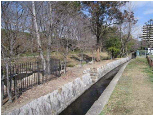
親水階段の設置されている大島井（2号水路）
