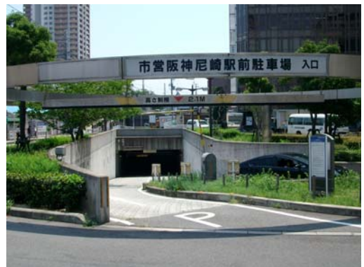
阪神尼崎駅前地下駐車場 入口
