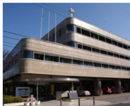
北部防災センター（地域の防災拠点）
