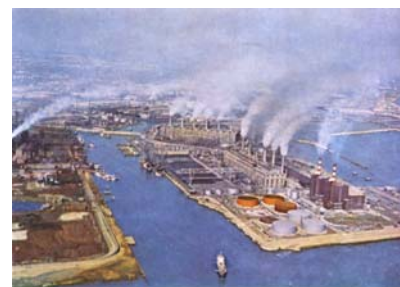
ばい煙を排出する発電所の煙突
