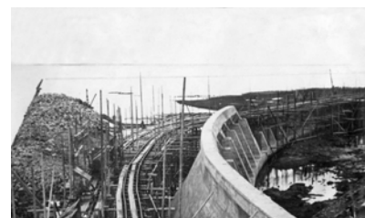
建設当初の防潮堤
