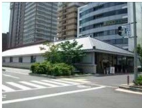
阪神尼崎駅南 自転車駐車場
