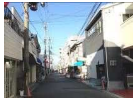
住宅への建替が進む商店街
