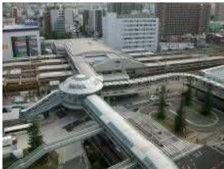
鉄道駅周辺の一体整備（JR 尼崎駅周辺）
