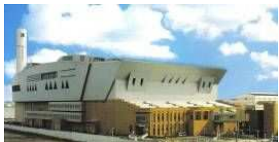
ごみ焼却施設（クリーンセンター第2工場）
