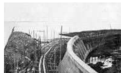
建設当初の防潮堤
