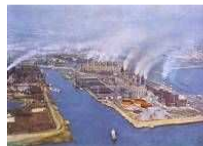
ばい煙を排出する発電所の煙突
