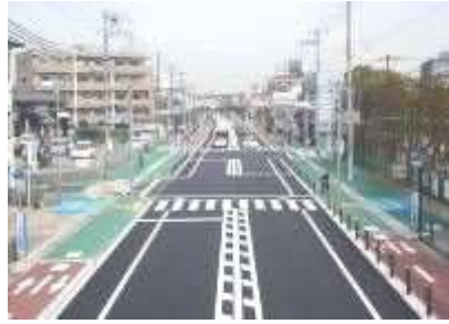
自転車道（神崎橋伊丹線）
