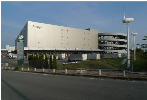
洗練された外観の大規模流通施設
