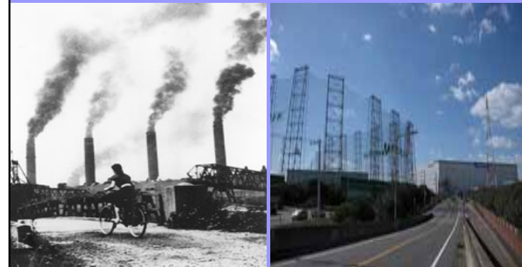
関西電力発電所(昭和31年頃 現在)
