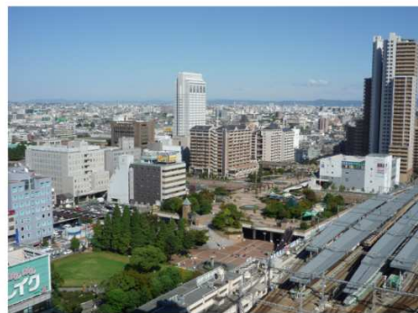
阪神尼崎駅周辺（北側）
