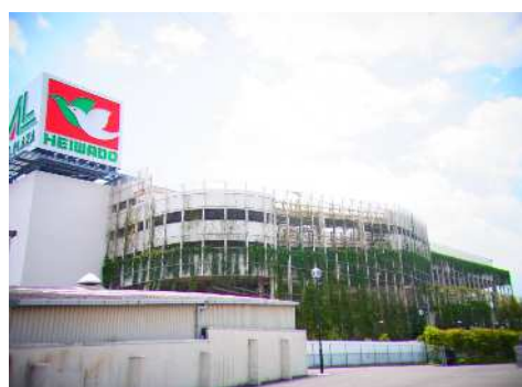
商業施設における建築物緑化
