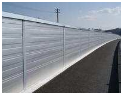
第2回グランプリ アルミ箔エコキューオン (神鋼建材工業株式会社) ・道路・鉄道向け防音壁、工場の外周・機械騒音の吸音材 ・従来のグラスウールなどの繊維系吸音素材を使用していない新たな吸音方式を採用されています。また、金属部材のみを使用することで全量をリサイクルすることができることなどが評価されました。
