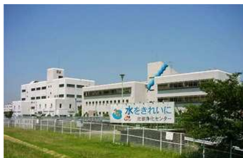
北部浄化センター
