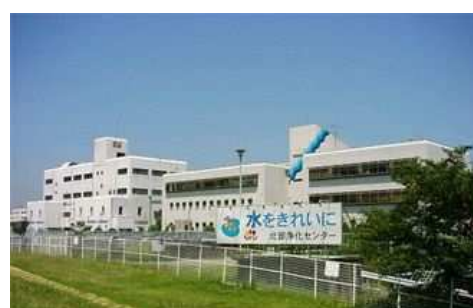
北部浄化センター
