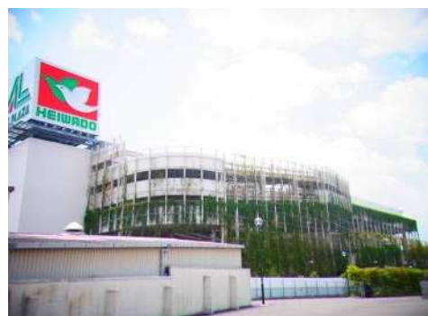
商業施設における建築物緑化
