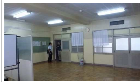
写真⑤：配膳室候補 内部
