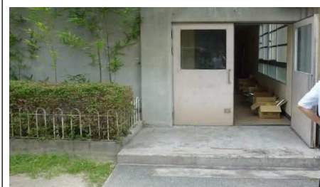
写真⑦：配膳室候補 搬入口
