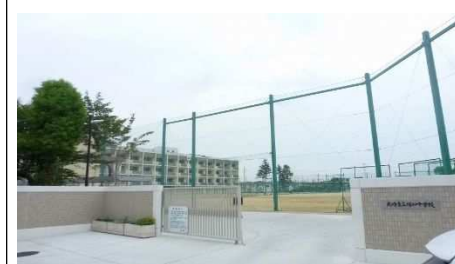
写真⑦：給食室候補 搬入口(西南門)
