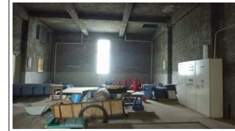
写真⑤：配膳室候補 内部
