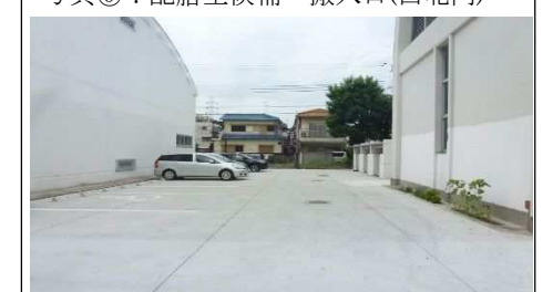
写真⑨：配膳室候補 搬入口(西北門)
