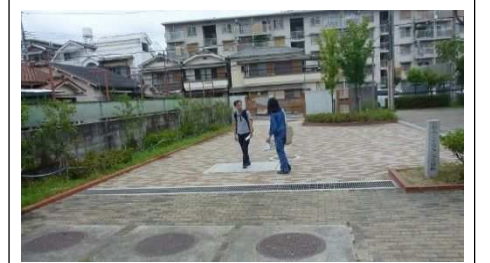
写真⑨：その他 貯水槽(埋設)
