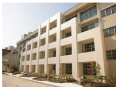
南武庫之荘中学校（北棟 補強）
