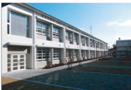
大庄北中学校（北棟 改築）
