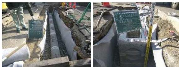
雨水浸透管・雨水浸透ますの設置
