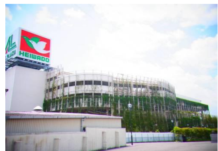
商業施設における建築物緑化
