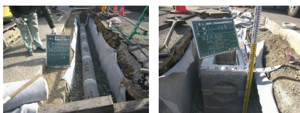
雨水浸透管・雨水浸透ますの設置
