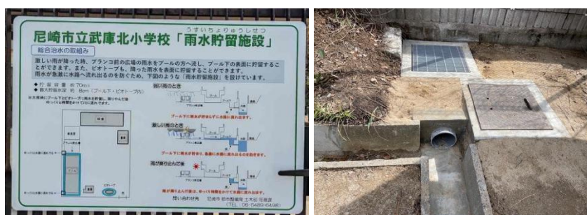
雨水貯留施設
