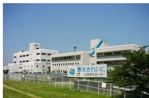
北部浄化センター
