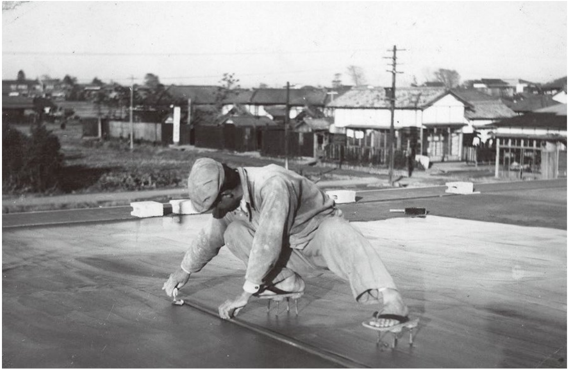
高下駄を履いてモルタル防水を施工する様子
