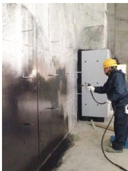
高下駄を履いてモルタル防水を施工する様子
