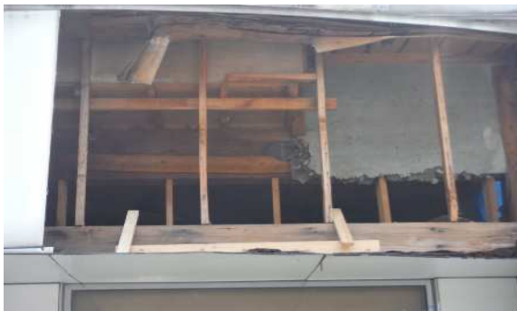
正面入口庇部分奥
