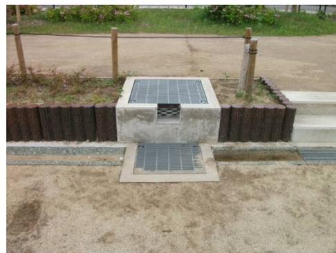
排水マス 貯留水深が 20cm を超えると、上段のマスから、小さくした排水口を経由せず下水道へ排水される。
