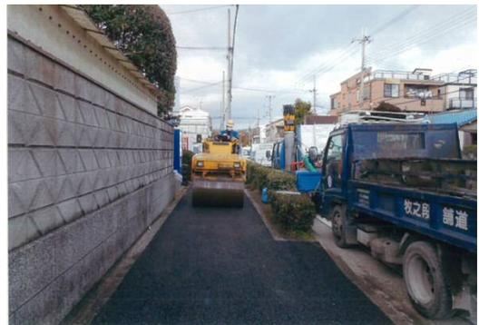
透水性舗装（透水性 As 転圧状況）
