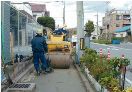
透水性舗装（フィルター層転圧状況）
