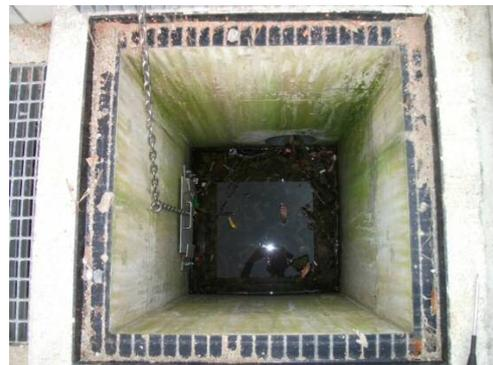
排水マス内部 小さくした排水口(ステンレス部)を経由し下水道へ排水される。
