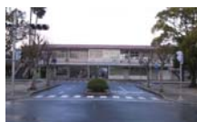
老朽化した管理棟
