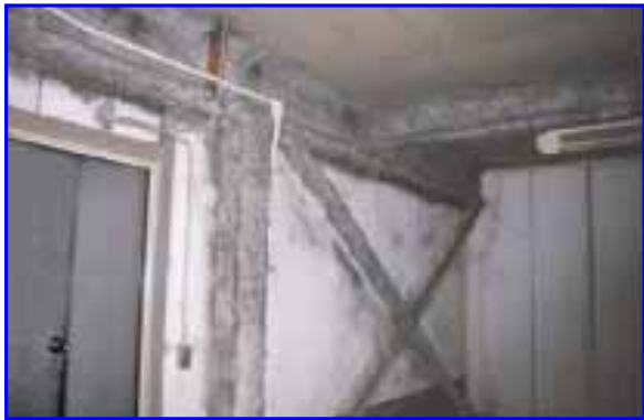
[柱・梁・天井などに吹付けられたアスベストの例]
