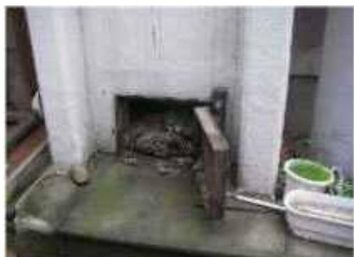
（剥離した断熱材が点検口付近に落下）
