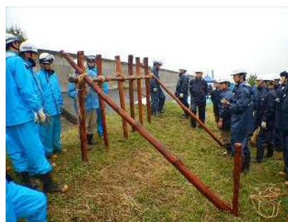
杭打積土俵工法
