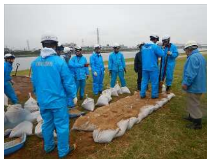
土のう積み工法
