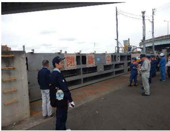
陸閘閉鎖作業
