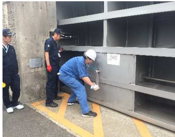
陸閘閉鎖作業
