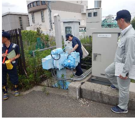
樋門閉鎖作業
