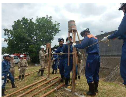
杭打積土俵工法
