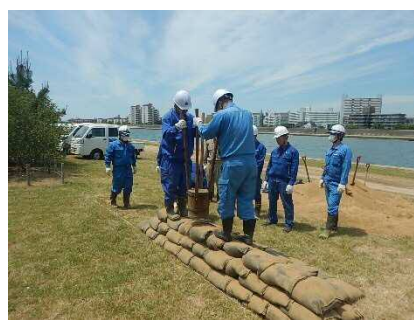
積み土のう工法
