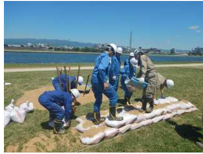
土のう積み工法
