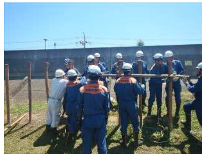
杭打積土俵工法
